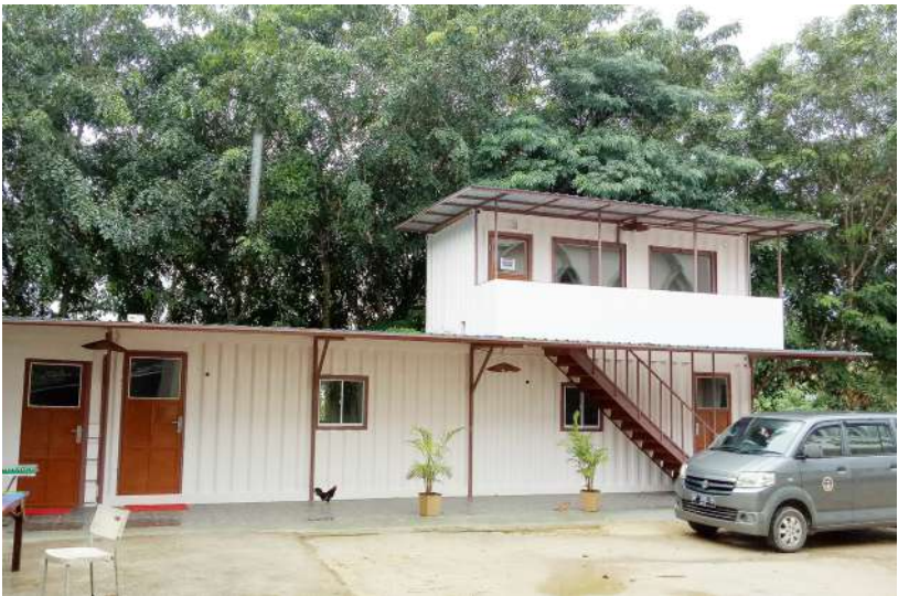
KANTOR GBKP KLASIS KEPRI DARI CONTAINER SUDAH SELESAI (Tanggal 3 Agustus 2017)
